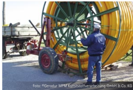
Bild 12: Ringbund auf Verlegewagen
