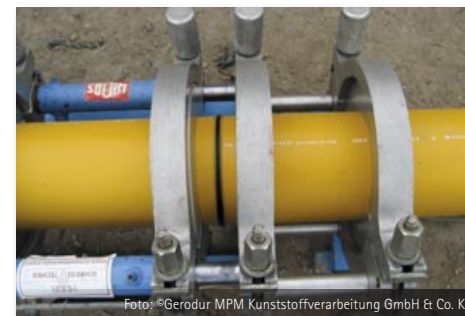
Bild 27: Heizelement-Stumpfschweißen
