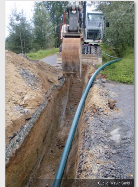
Einbau eines PE 100 RC-Druckrohres im offenen Graben
