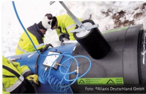
Bild 16: Arbeiten bei niedrigen Temperaturen
