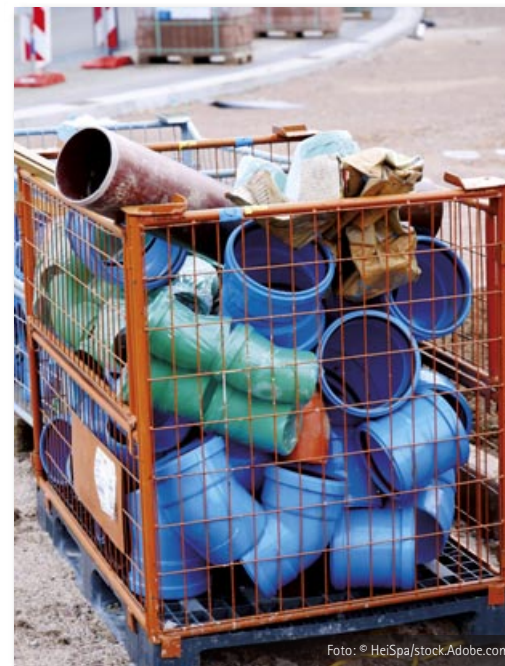
Bild 1: Gitterbox zum Sammeln von Kunststoffrohrresten auf der Baustelle
