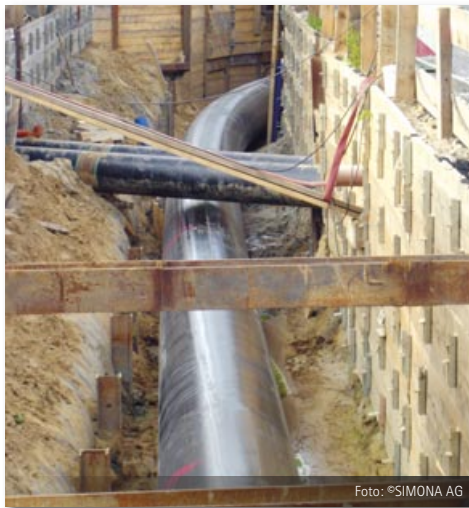
Bild 15: Abwasserdruckrohrleitung aus PE
