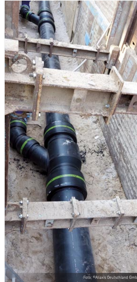
Bild 34: Einbau im Graben mit Sandbett
